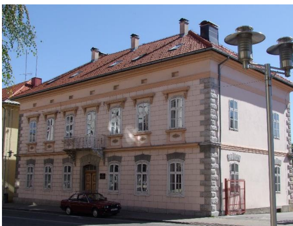
Slika 11 Zgrada Državnog arhiva u Gospiću
