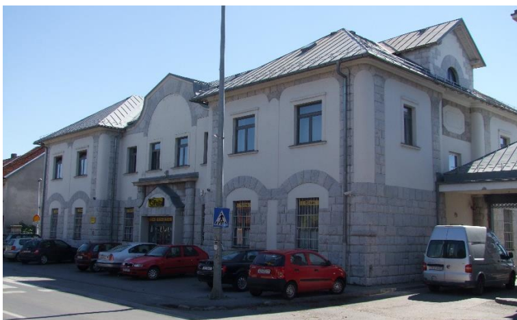
Slika 14 Zgrada pošte u Gospiću Izvor: https://registar.kulturnadobra.hr/#/details/Z-6307
