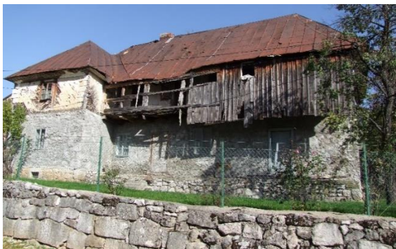
Slika 4 Kuća u ulici Mlinarska 1 u Gospiću
